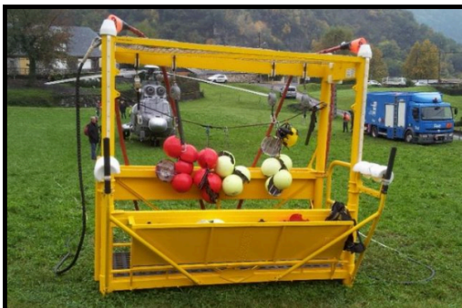
Pyrénées : des balises sur les lignes haute tension avertissent les rapaces du passage des câbles
